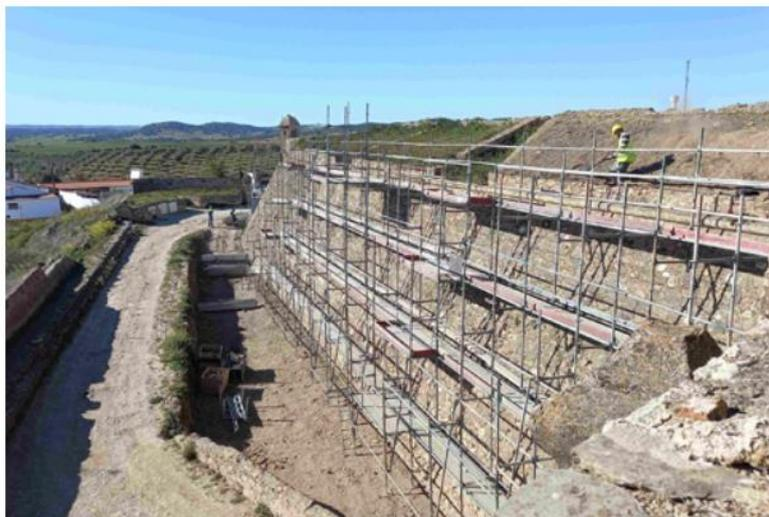
Para além da consolidação e reforço estrutural dos paramentos, sobretudo nas zonas mais degradadas, está também prevista a reconstrução de diversos tipos de alvenaria, como pedra, tijolo e taipa.
